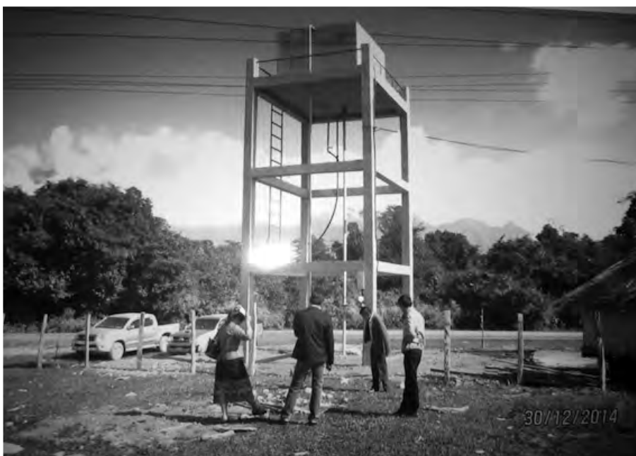
ポンカン村に建設された水供給施設
