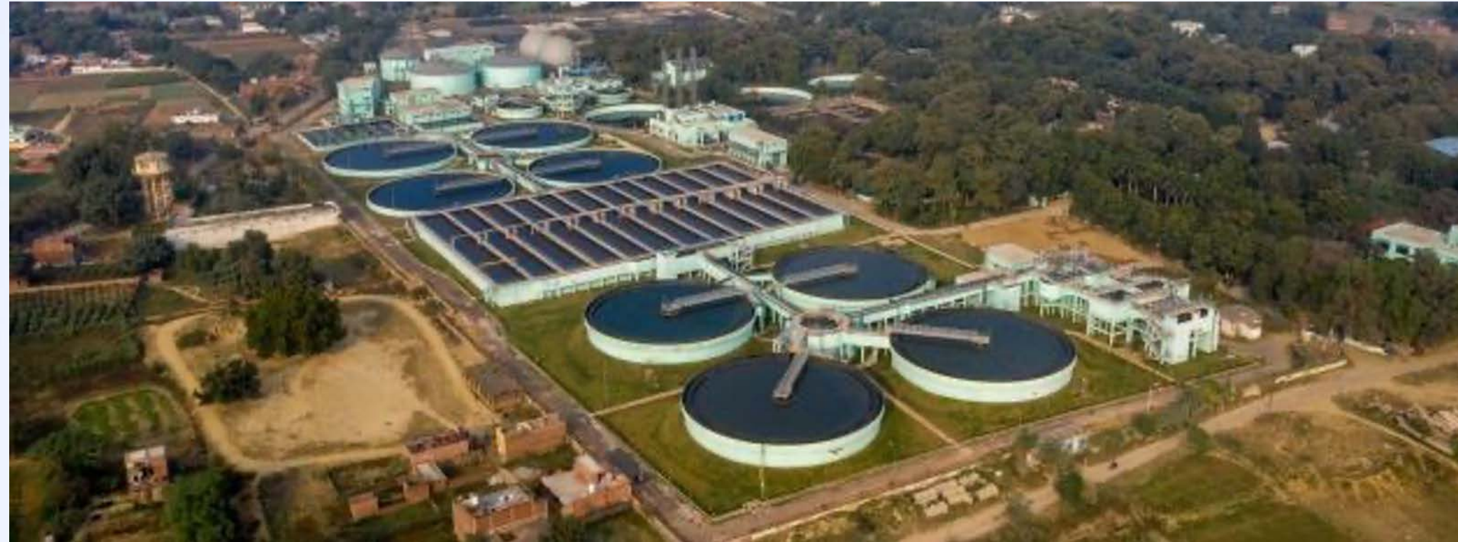
140 MLD STP Dinapur, Varanasi
