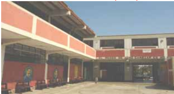
イカから北へ4kmのサン・ホセ・デロス・モリス 広: 短い柱によって被害を受けた。1997年地震震害によって立てられた建物 左: 新1997年地震震害によって立てられた建物の建物
