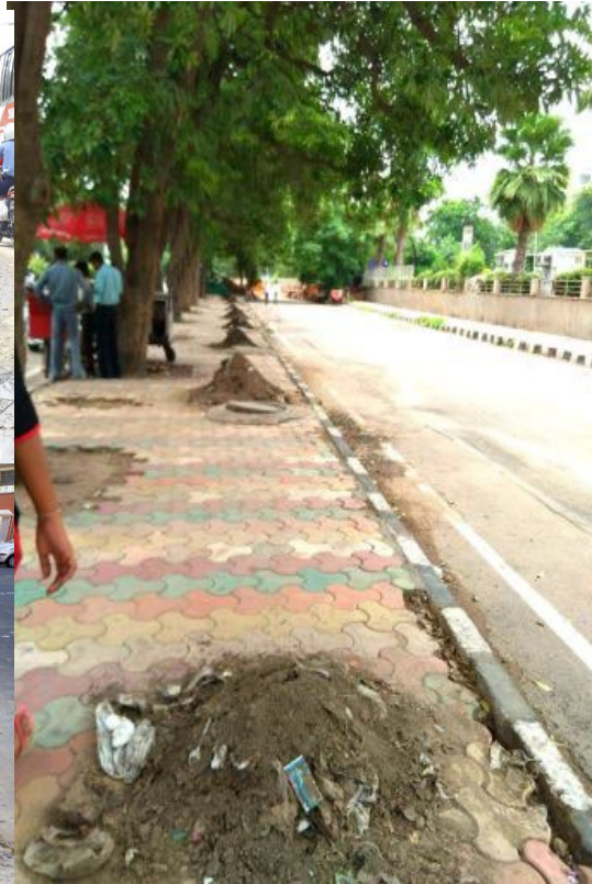
Tanah yang digali di atas trotoar pejalan kaki. Kredit foto: Pallavi
