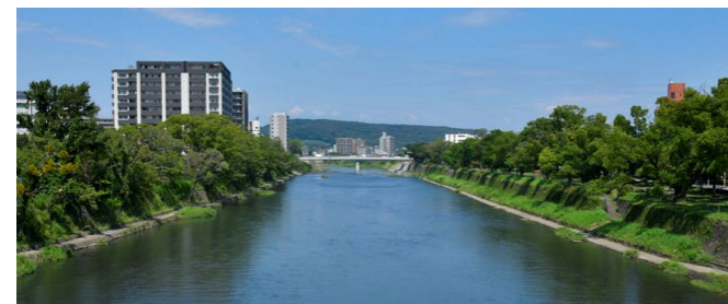
▲河道の拡幅がなされた区間
