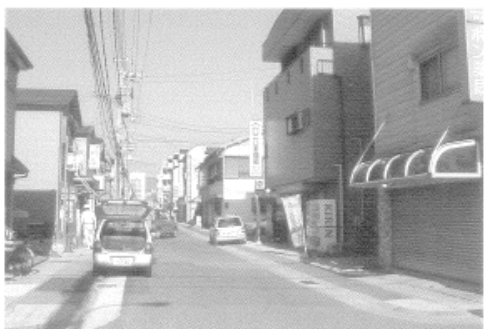
整備された区画道路（幅員8m）
