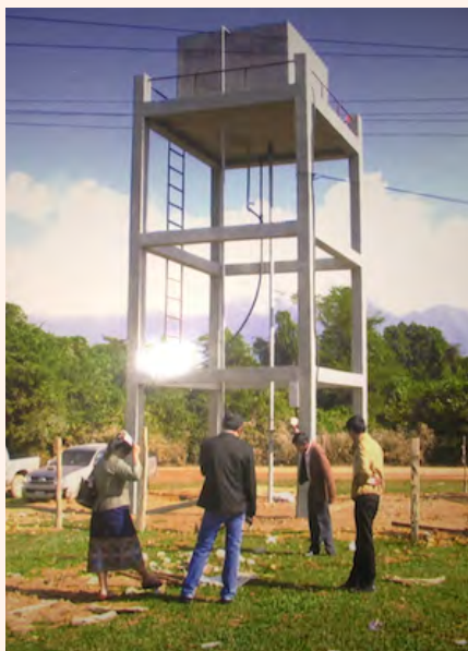
ポンカン村に建設された水供給施設
