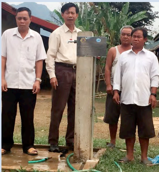
ポンカン村で拡張された水供給施設
