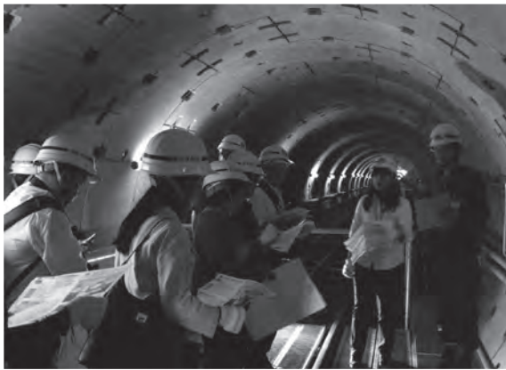
雨水を貯める貯留管工事の現場視察
