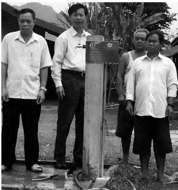
ボンカン村で拡張された水供給施設
