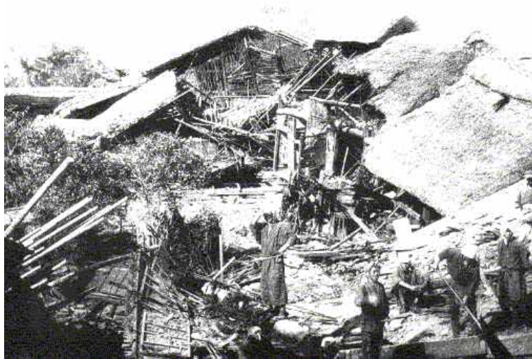
Foto 1: Daños en una vivienda de madera causados por el Terremoto de Nohbi (1891)
