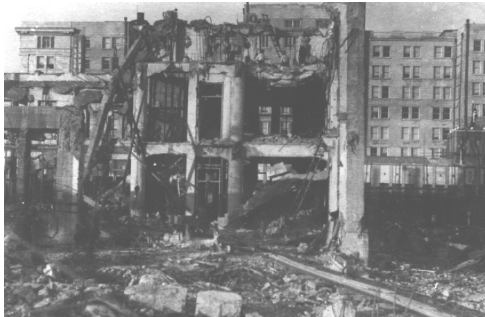
Foto 2: El edificio Naigai recientemente terminado colapsó
