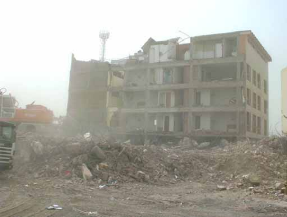
Foto 3: Demolición del Hotel Embassy en la ciudad de Pisco
