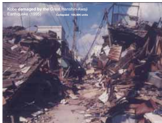
Foto 2: Viviendas colapsadas en Kobe
