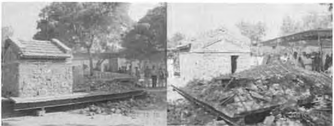
11 回目の振動による被害 (P5-20)
