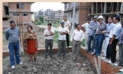
建築現場での現地視察
