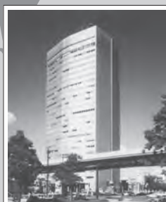
国際連合地域開発センター (UNCRD) (名古屋国際センタービル内)
